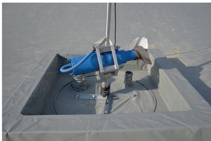
Einbau eines ORKA in einer Folienlagune
