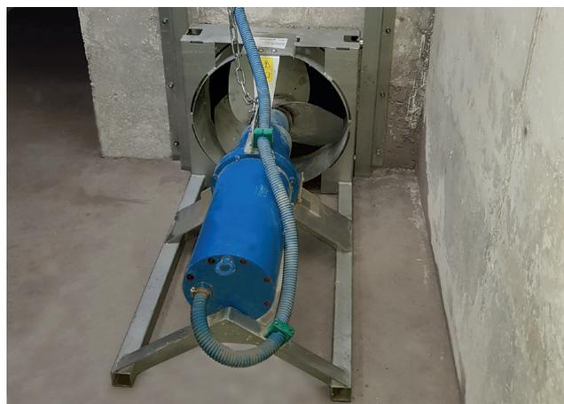
Einbau eines ORKA im Gülle-Kanalssystem mit Z-Schienen
